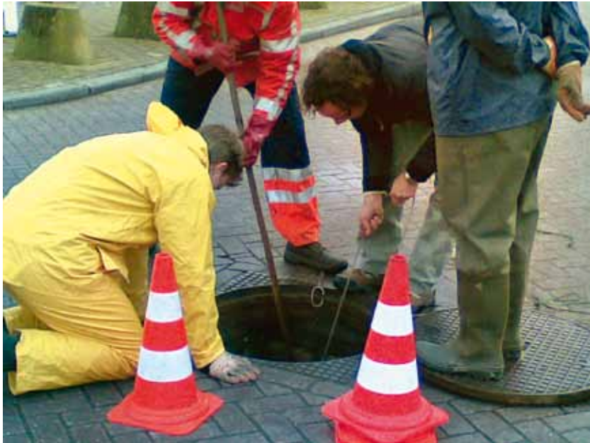
Figuur 4.4 Kabel van put naar put trekken
