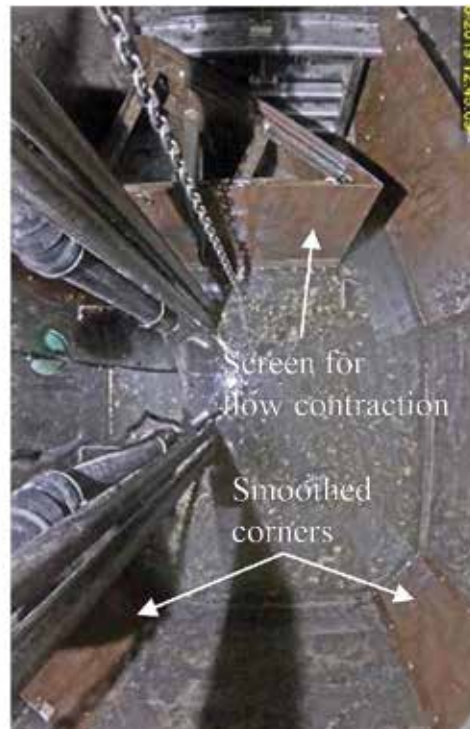
Figuur 9 Screenshots van de camera in gemaal G0156 Nieuw Terbregge. Links: originele ontvangstbassin. Rechts: aangepast bassin. Voor het aanvoerriool is een scherm geplaatst om de stroming naar de wand te geleiden (screen for flow contraction). De schuine hoeken (smoothed corners) zorgen voor een geleiding van de stroming zodat er voldoende circulatie ontstaat.
