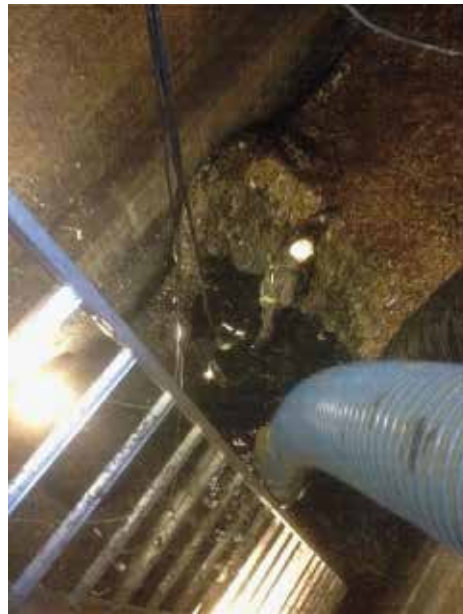
Figuur 3. Links: het handmatig verwijderen van een laag drijfvuil. Rechts: detail van de drijflaag met een dikte van bijna 2 m.
