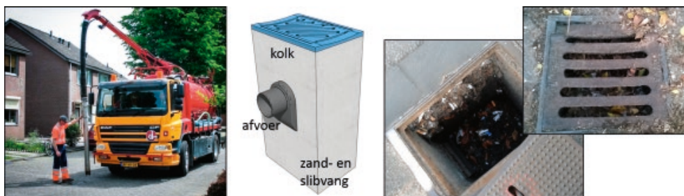
Figuur 3.1 Kolken reinigen (links), schematisch overzicht kolk (midden) en vervuilde straatkolken (rechts)
