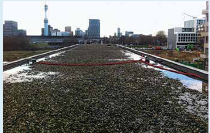
Zwart 'referentiedak' met op de voorgrond een klepgestuurd deel en op de achtergrond een vrij afwaterend deel. (Foto: Rob Tijsen)
