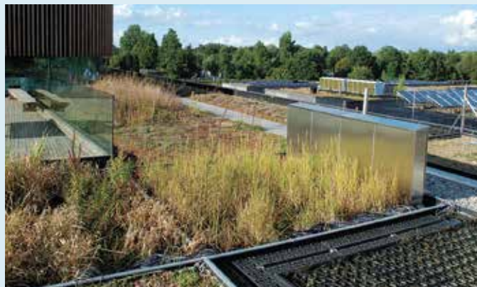
De indeling van het NIOO-KNAW Daklab bestaat uit 45 plots van 8 m 2 (Foto: NIOO-KNAW)
