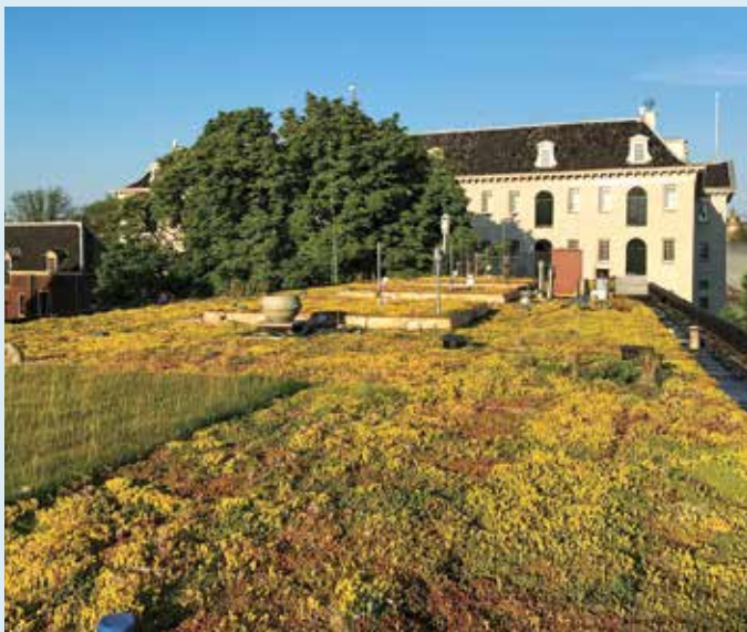
Overzicht van het meetdak met zichtbaar verschil tussen de sedum-mixmatten en een vegetatietest met grasmatten.
