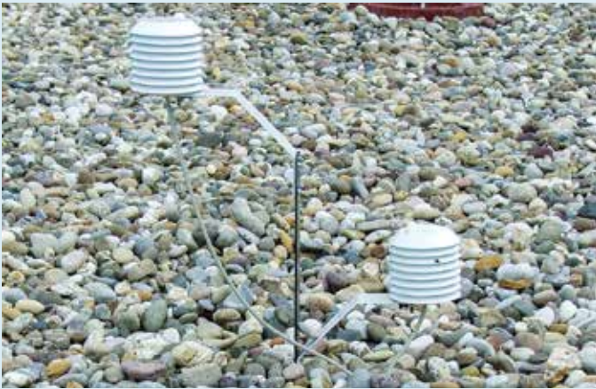
Meetapparatuur op het dak. (Foto: Michiel Rijdsdijk)
