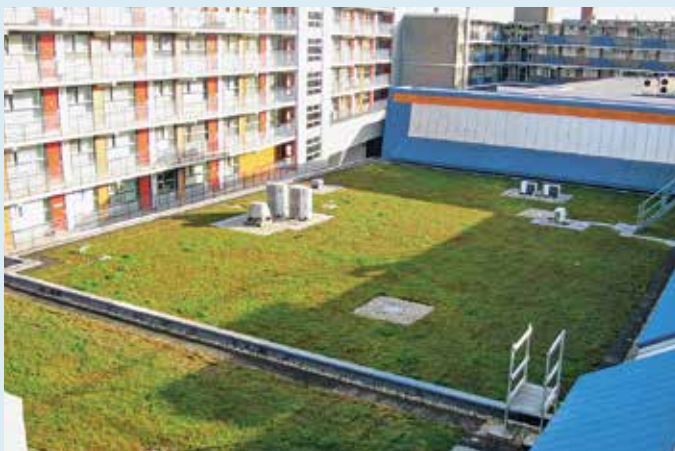
Groen dak 700 m 2 .
