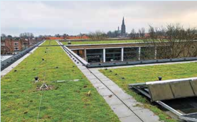
Sedumdaken na aanleg. (Foto: Universal Greenfields)
