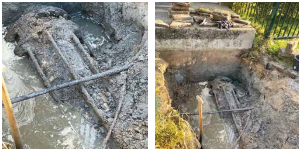
Figuur 5.10 Proefsleuf met pendelstuk
