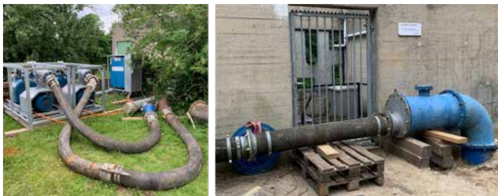
Figuur 5.17 Tijdelijke pompinstallatie (l) met aansluiting op de lanceerinrichting (r).
