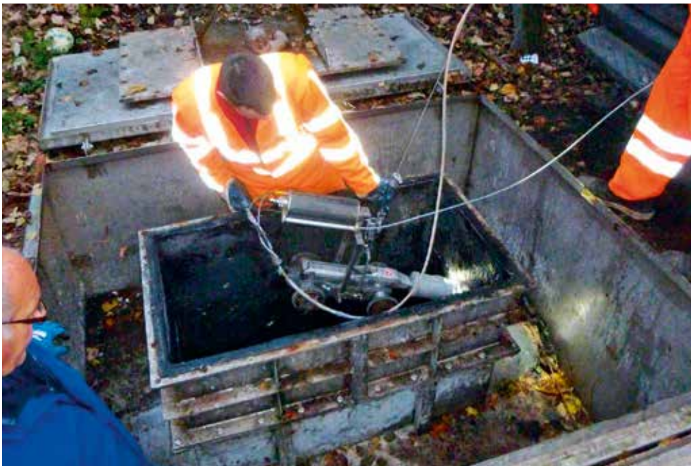
Figuur 5.3 Inbrengen inspectieapparatuur. Foto Waterschap Brabantse Delta.
