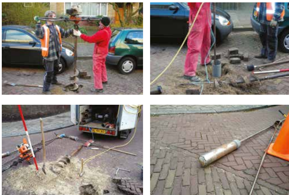
Figuur 5.7 Nemen van boorkern. Foto's N. Stanic (2013).
