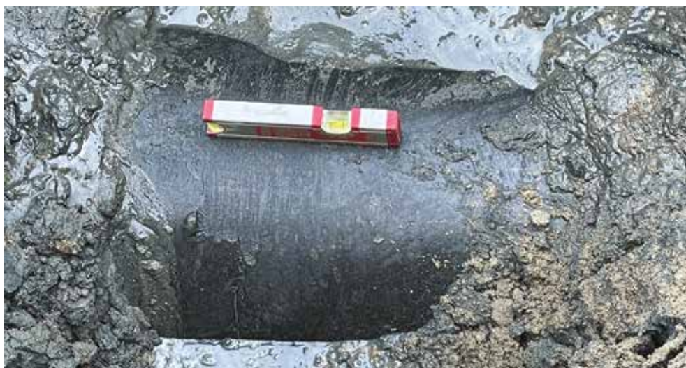
Figuur 5.11 Inmeten zakking leiding naast gemaal
