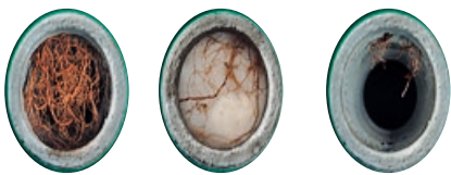
Figuur 6.1 Chemische behandelingsmethode (bron: RootX)
