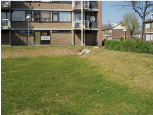
Figuur 6.8 Uitstroom bij flatgebouw.
