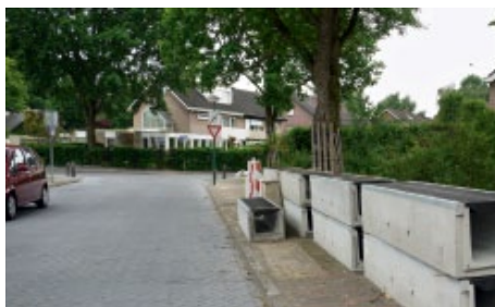
Figuur 2.11 Aanleg roostergoten.
