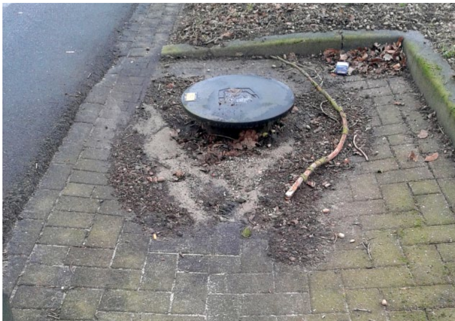
Figuur 7.10 Vuillast bij een opvangput na een hevige bui.
