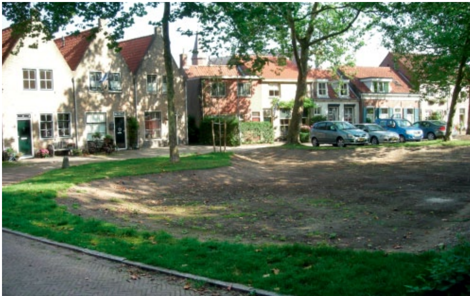
Figuur 5.8 Berging in een groenvoorziening (in aanleg).
