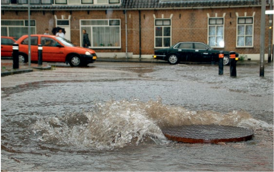
Figuur 13.2 Een weggedrukte putdeksel zorgt voor een gevaarlijke situatie.
