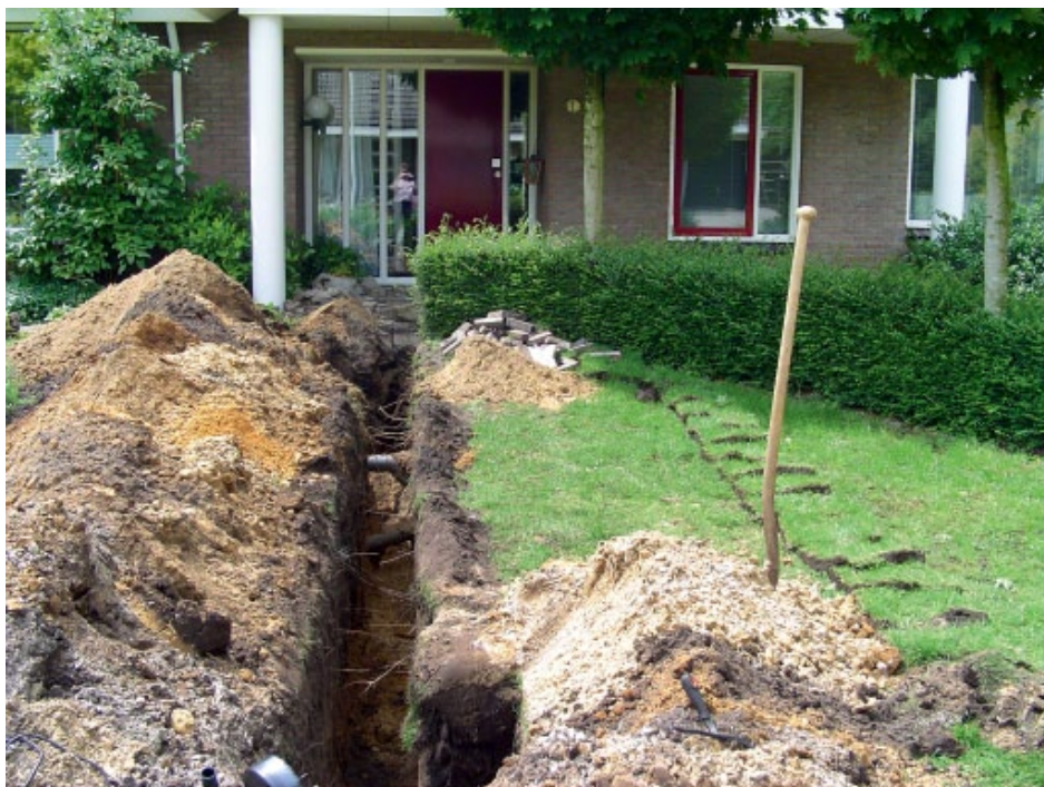
Figuur 8.2 Afkoppelen regenwater van een woning.
