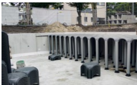
Figuur 2.10 Aanleg bergingskelders (Waterblock).
