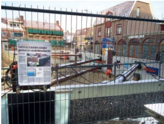
Figuur 4.4 Aanleg infiltratiebassins in het centrum.
