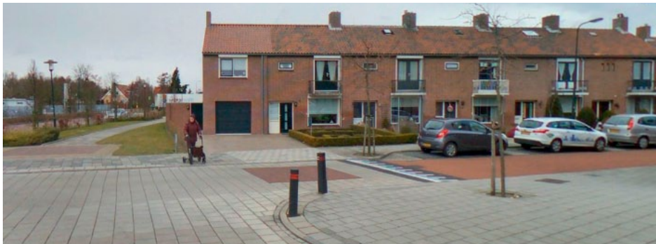
Figuur 5.4 Verkeersplateau houdt water op straat tegen.
