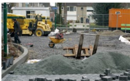
Figuur 2.9 Aanleg doorlatende en bergende verharding (Aquaflow).
