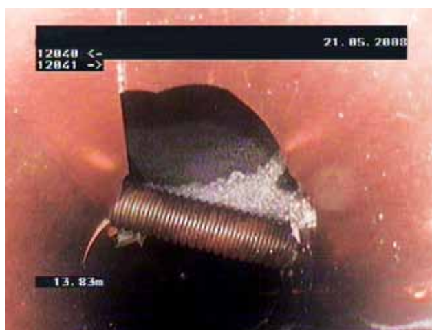
Figuur 1.1 Kunststof rioolbuis zwaarbeschadigd door raketboring
