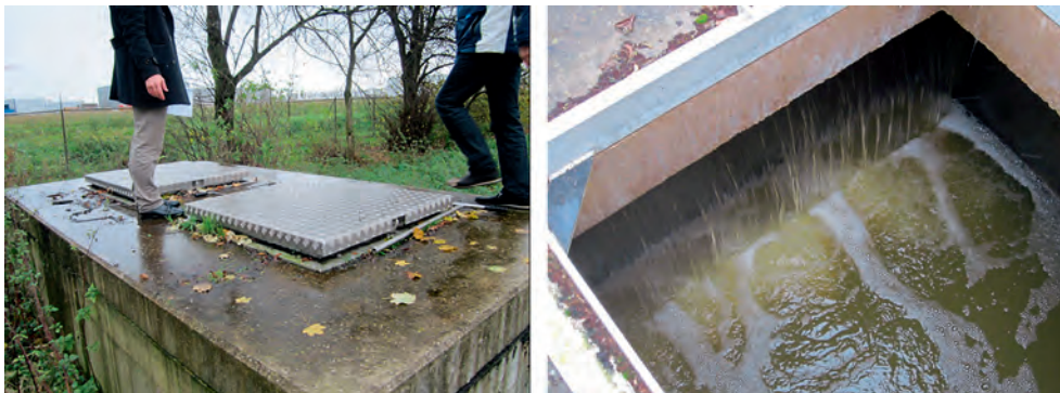
Figuur 2.6 Ontvangstput van helofytenveld (links) en interne overstort in put (rechts)
