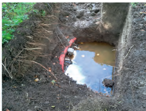
Figuur 2.12 Monsternamekast bij ontvangstput helofytenveld (locatie C, links) en opgegraven debietsensor in aanvoerende persleiding (rechts)
