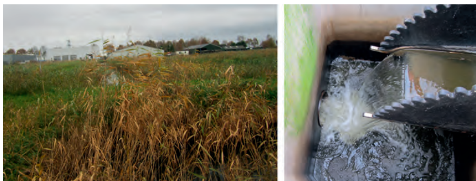
Figuur 2.8 Begroeid vloeiveld in zomerseizoen (links) en uitstroomconstructie na vloeiveld 3 (rechts)
